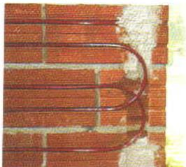
Réaliser le premier passage comme indiqué ci-dessus. Une fois au bas du mur, faire remonter le tube dans les rainures horizontales restantes, en croisant les tubes en bord de mur.
