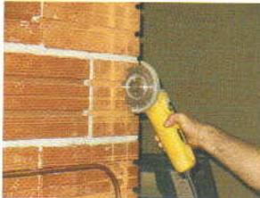
Scier les briques à 6 cm et à 13 cm du bord du mur, sur une profondeur approximative de
